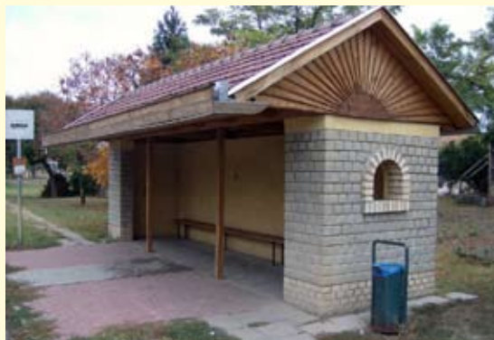
Biotéglából épült buszmegálló Csorváson
